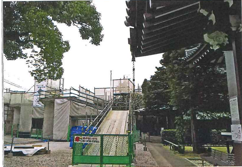
（上）作業場で木材を見る天野哲也さん （下）現在、本堂改修工事を手掛けている東京都大田区の安詳寺
